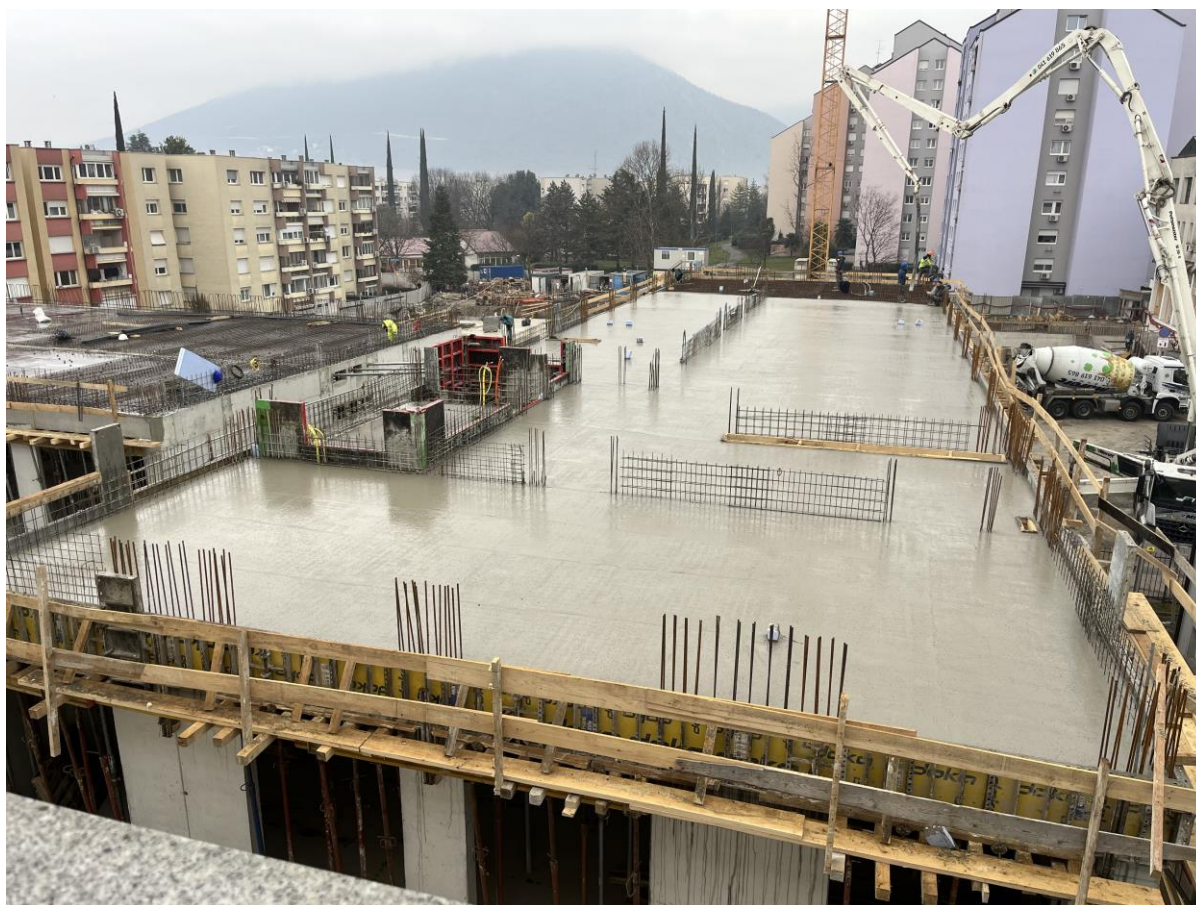
Gradnja III. faze ZD Nova Gorica, februar 2024
