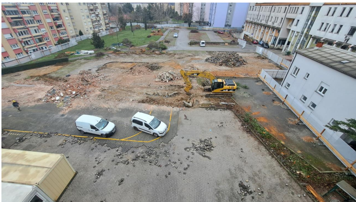
Začetek gradnje III. Faze ZD Nova Gorica
