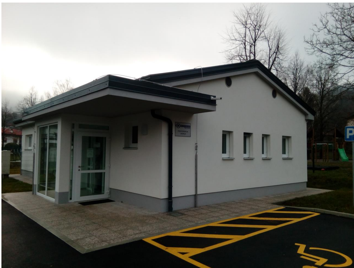
Nova stavba Fizioterapije v Desklah, januar 2020
